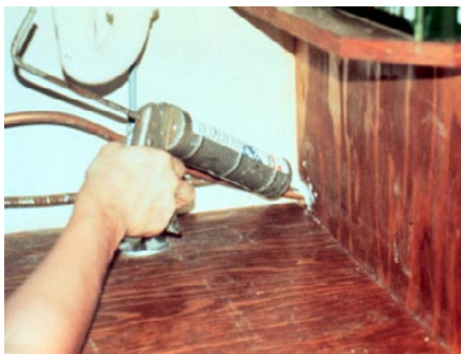
Figura 5-9. Use masilla para sellar las grietas, hendiduras y los huecos para eliminar estos escondites de cucarachas.
